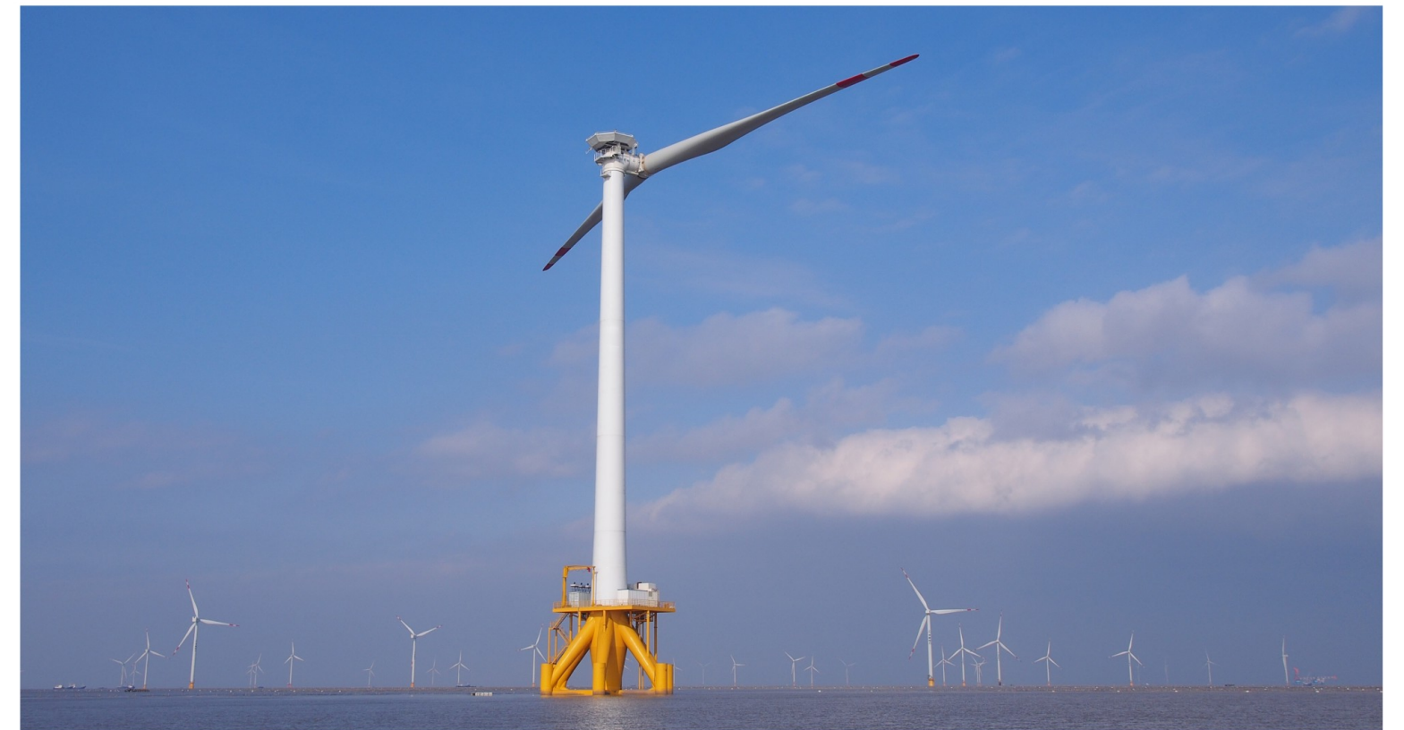
2014年，全球单机容量最大的超紧凑型SCD6.0/6.5风机在江苏如东国家试验风电场吊装成功，并于2015年并网发电
