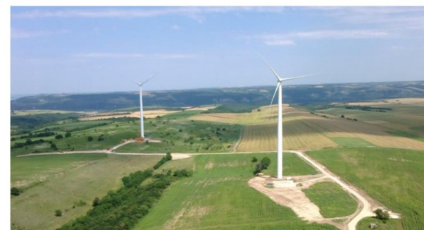
■ 2012年6月，明阳在东欧市场与W Power Group共同开发位于保加利亚125MW风电项目，首期5MW示范项目投入商业运行
