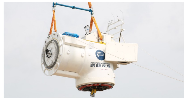
珠海桂山海上风电场主机吊装
