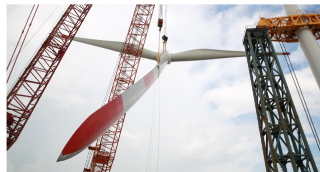
珠海桂山海上风电场叶片吊装
