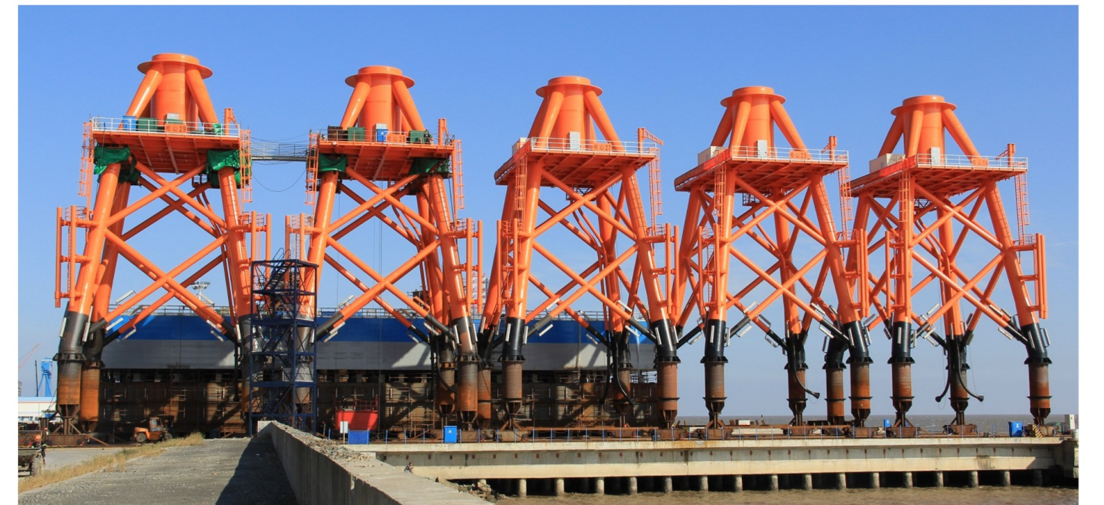
珠海桂山海上风电场工程示范项目导管架基础
