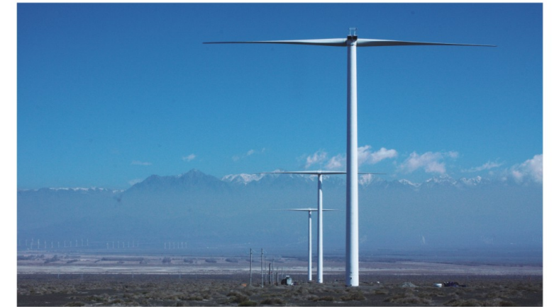
2010年，超紧凑型SCD3.0MW风机在新疆达坂城风电场成功吊装
